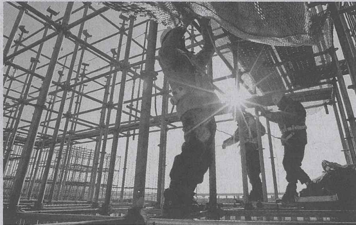
시스템 비계를 설치 중인 건설현장.
