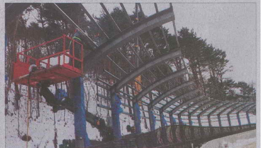
◇슬라이딩센터 공사 모습.
