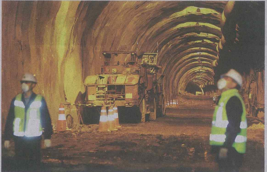
신월빛물저류 배수시설 공사 한창 16일 오후 서울 양천구 신월빛물저류 배수시설 공사현장에서 작업자들이 배수시설 확충 작업을 하고 있다. 2017년 배수터널이 완공되면 양천, 강서지역에 장마철 집중호우 시 40여m 지하의 직경 10m, 길이 3.6km 배수터널에 32만t의 빗물을 일시적으로 저장할 수 있다. 안윤수기자 ays77@
