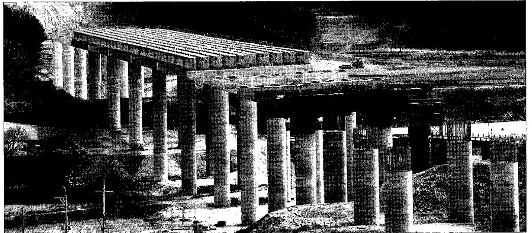
◇2018평창동계올림픽 성공 개최와 중부내륙권 발전의 기폭제가 될 제2영동고속도로 공사가 2016년 11월 개통을 목표로 한창인 가운데 원주시 지정면 6공구의 삼산교가 위용을 드러내고 있다. 원주=오윤석기자
